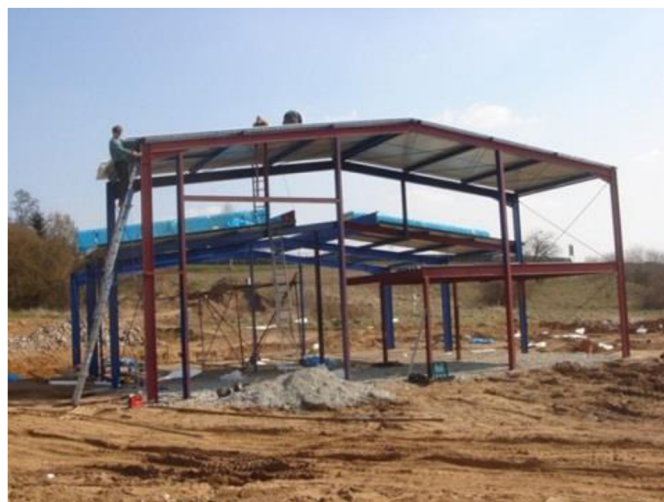
Obrázek 4 Hala Aldo metal zdroj: Aldo metal s.r.o
