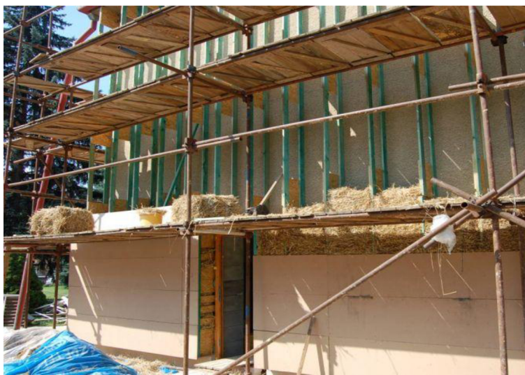
Obr. 3: Mateřská škola Pitín- Zateplení obvodových stěn slaměnými balíky o tloušťce 400 mm
