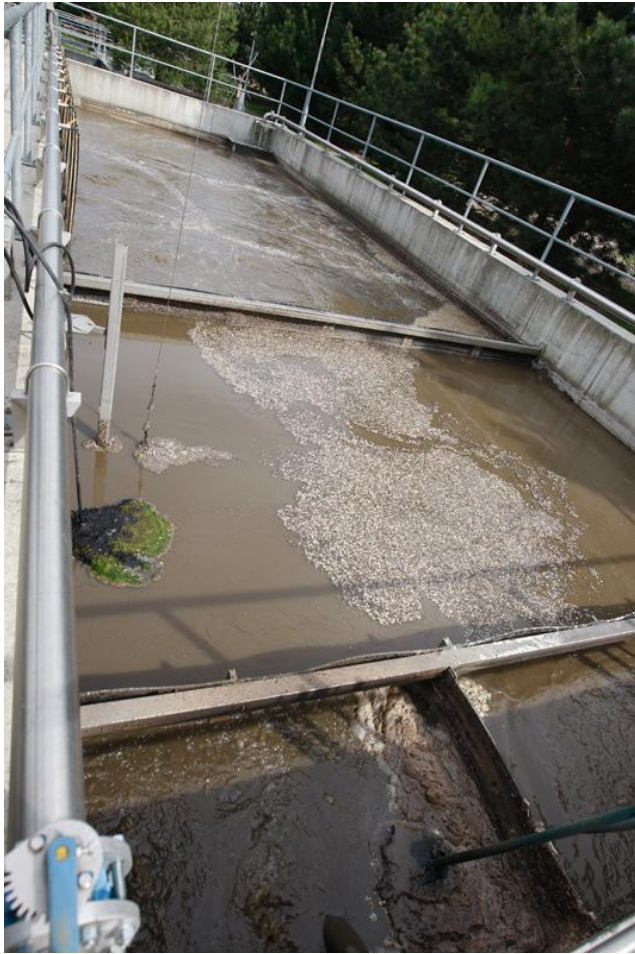
Obr.7 ČOV Zeleneč - aktivační nádrže. Selektor nejbližší, uprostřed denitrifikační a vzadu nitrifikační aktivátor kalu, Skoková, 2011.
