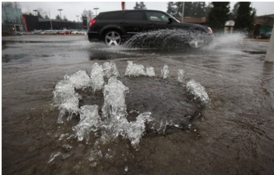
Obr. 5: Výtok vody na povrch jako odpověď kanalizační sítě na přívalový déšť v americkém městě Seattle v roce 2010. Zdroj: http://www.seattlepi.com .
