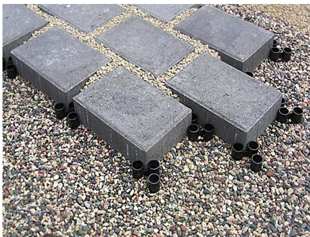
Obr. 9: Pokládka betonové dlažby na štěrkovou vrstvu. Zdroj: http://www.hardscapemagazine.com .
