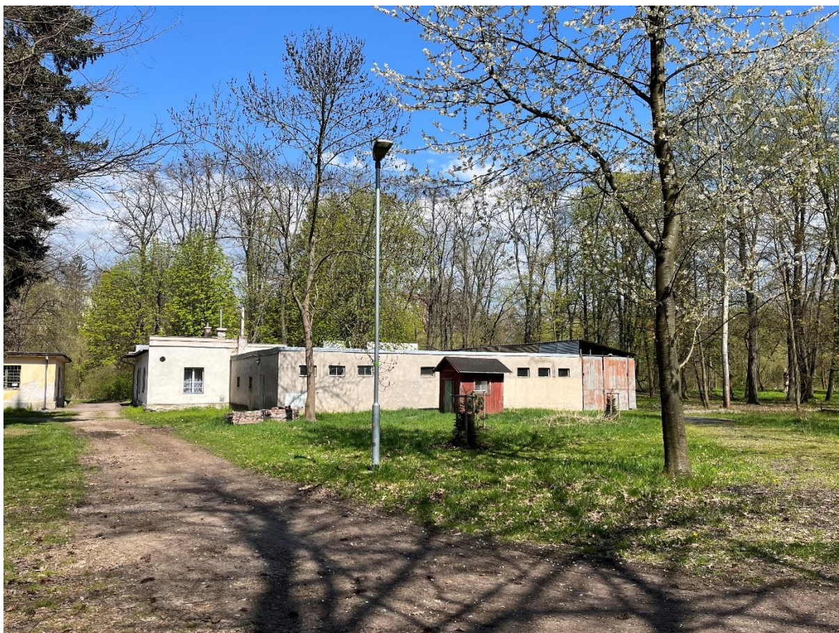
Příloha č. 5: Chátrající budovy v parku stará vojenská plovárna Zdroj: Michal Hofman
