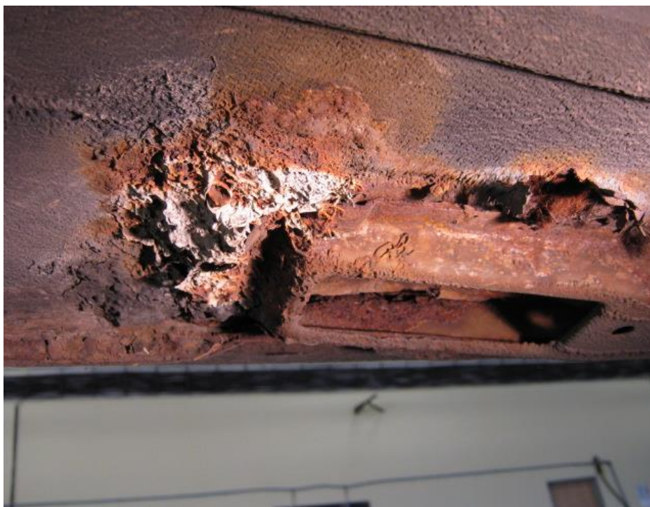
Obrázek č. 33 Koroze podlahy Škoda 1203 (vlastní foto)
