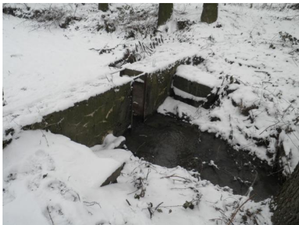
Foto č. 6 – Pohled JZ, odtokový objekt
