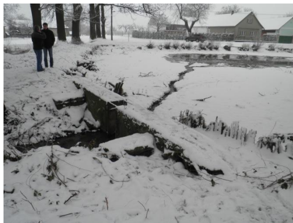
Foto č. 7 – Pohled V, odtokový objekt
