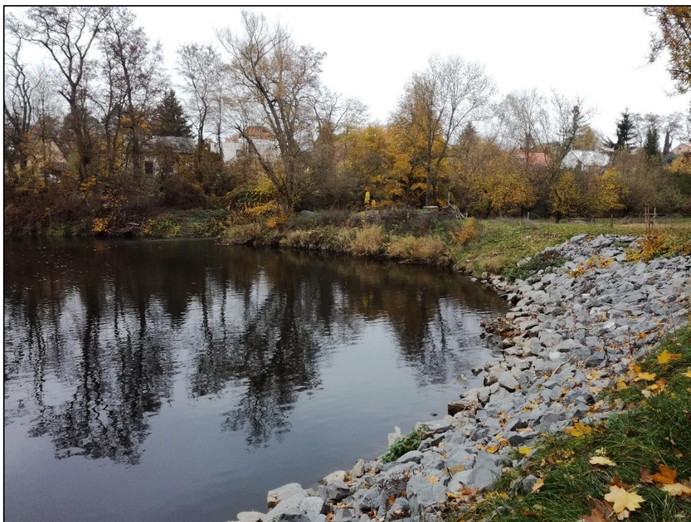
Příloha 20: Fotografie zpevnění pravého břehu v Bakově nad Jizerou
