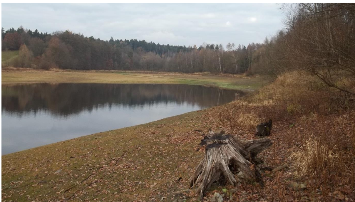
Obr. 41 Hustě porostlé okraje vodní nádrže Tršice (zdroj: M. Češek)
