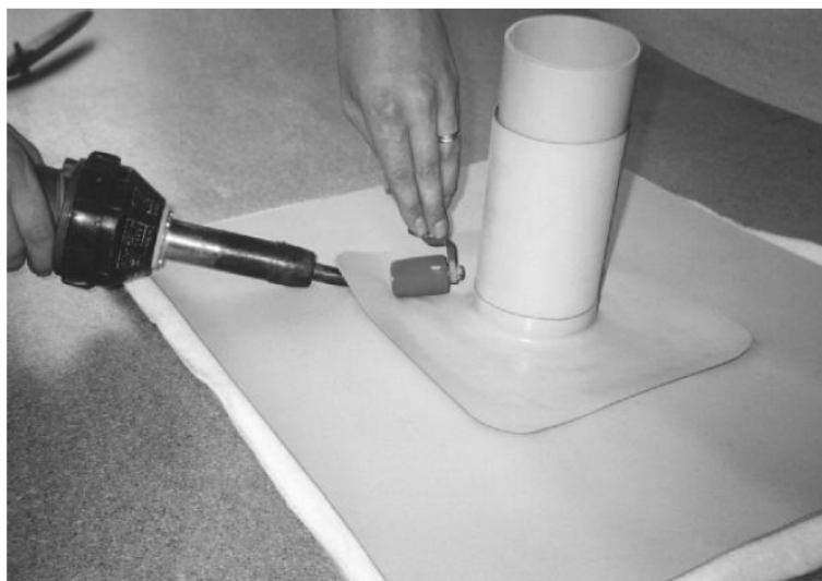
Cel plošné navaření manžety k fólii
