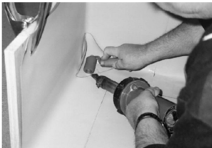
Navaření koutové tvarovky
