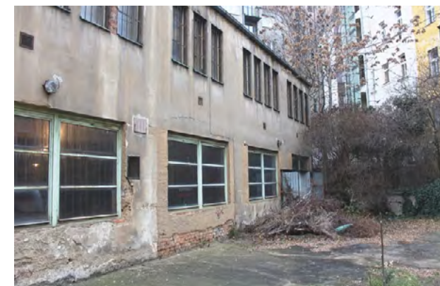
Obr. 26. Zanedbaný vnitroblok v Holešovicích (www.kauza3.cz)
