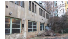
Obr. 26. Zanedbaný vnitroblok v Holešovicích (www.kauza3.cz)
