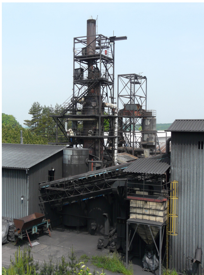
Obr. 16 Karbonizační retorta typu Lambiotte (SERVIS LES ČINĚVES 2008)
