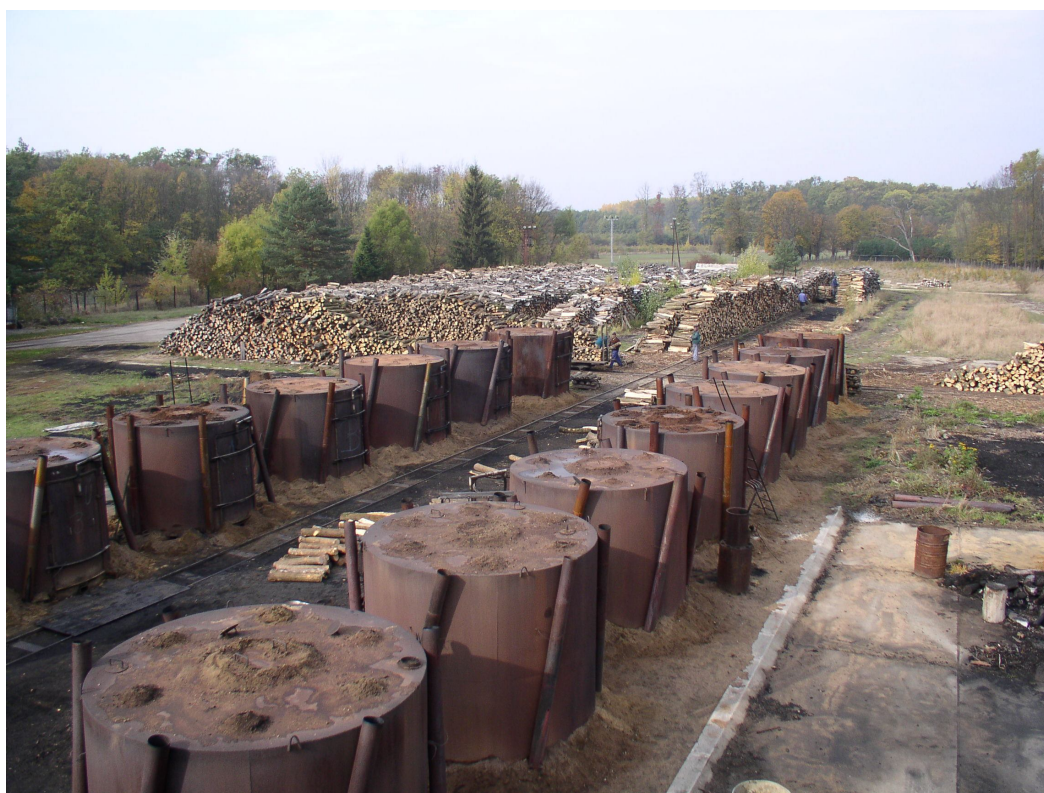
Obr.17 Kruhové ocelové karbonizační pece (LČR s. p., LZ ŽIDLOCHOVICE 2000)
