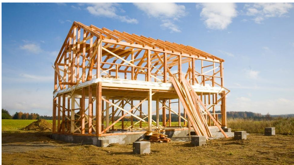
Obr. č. 3 – Rámová stavba (zdroj: http://www.woodsystm.cz/data/images/696.jpg )
