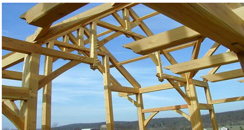
Obr. č. 4 – Skeletová stavba (zdroj: http://www.tess-drevostavby.cz/images/layout/skelet-tezky.jpg )
