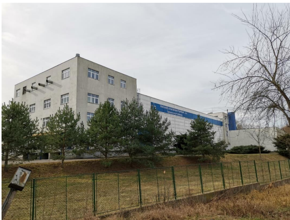
Obrázek 5 Úpravně vody Poděbrady, zásobuje město Poděbrady pitnou vodou, budovu vlastní firma Vak Nymburk a.s.
