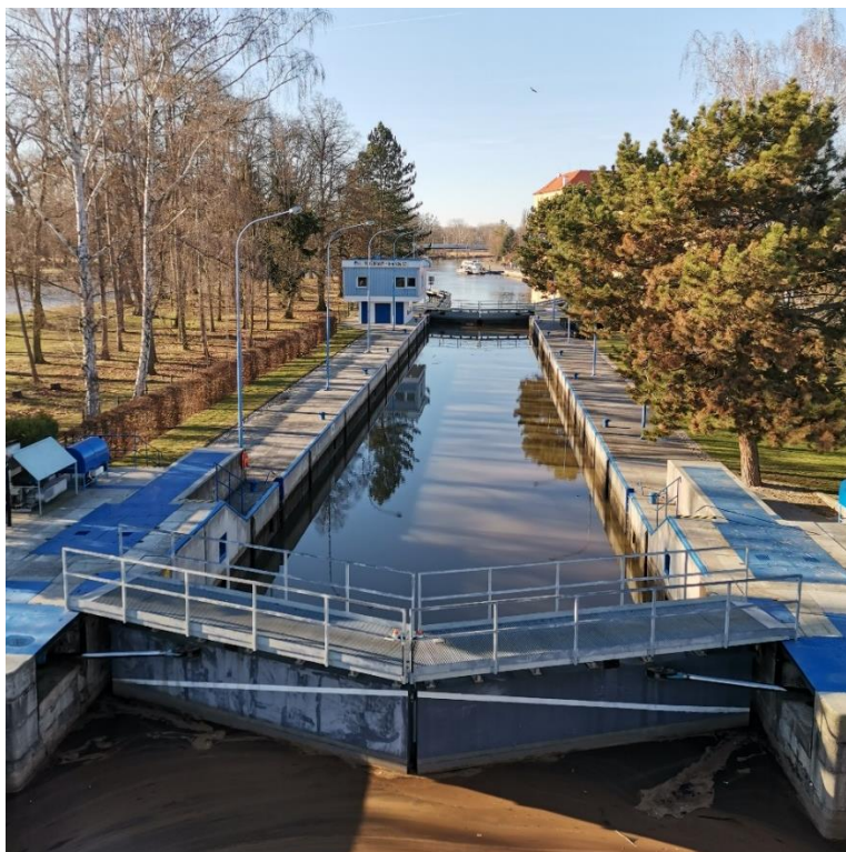
Obrázek 2 Plavební komora zajišťuje vertikální přemístění lodí, nachází se na pravé straně řeky Labe mezi starým labským ramenem zvaným Skupice a jezem na Labi, Poděbrady.
