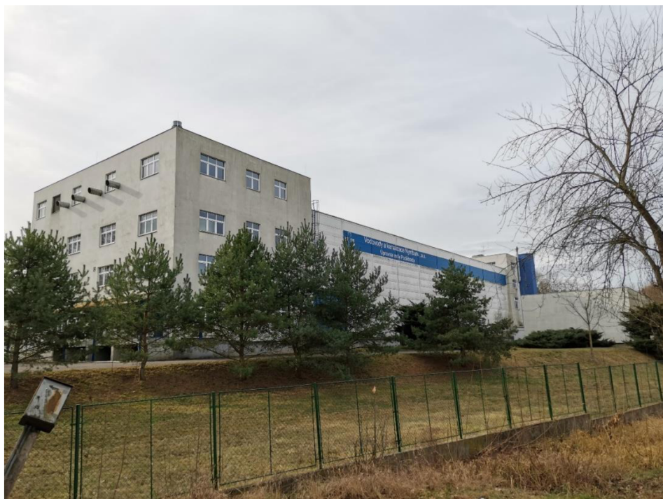
Obrázek 5 Úpravně vody Poděbrady, zásobuje město Poděbrady pitnou vodou, budovu vlastní firma Vak Nymburk a.s.
