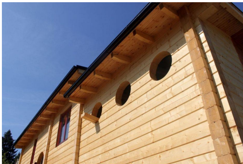
Obr. č. 13 Novodobá srubová konstrukce z lepeného dřeva (Zdroj: Sopík, 2019)
