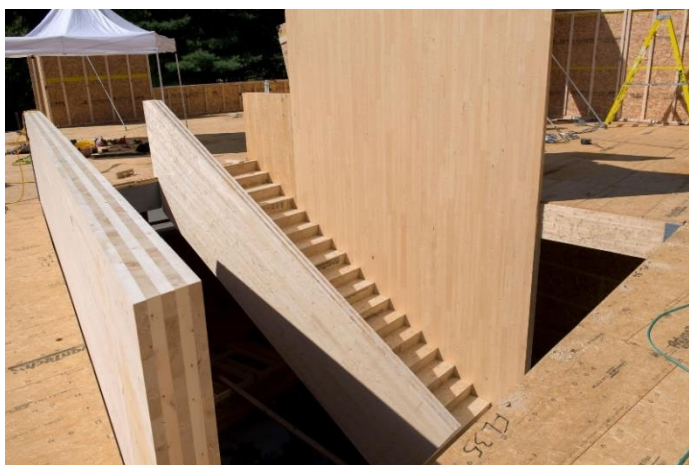
Obr. č. 26 Ukázka křížem slepeného dřeva
