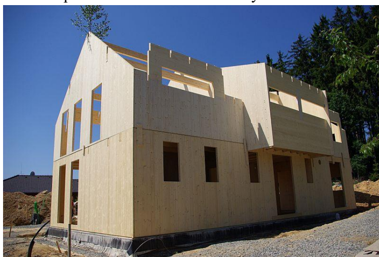
Obr. č. 25 Ukázka konstrukce z masivního dřeva
