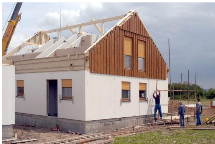
Obr. č. 20 Ukázka montáže rámové dřevostavby
