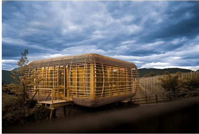
Obr. č. 29 Moderní modulární dřevostavba FINCUBE
