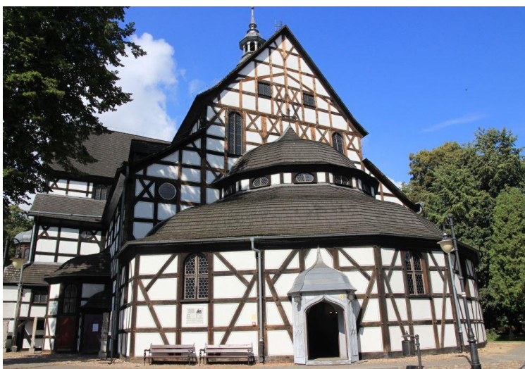
Obr. č. 15 Tradiční hrázděná konstrukce – Kostel Míru
