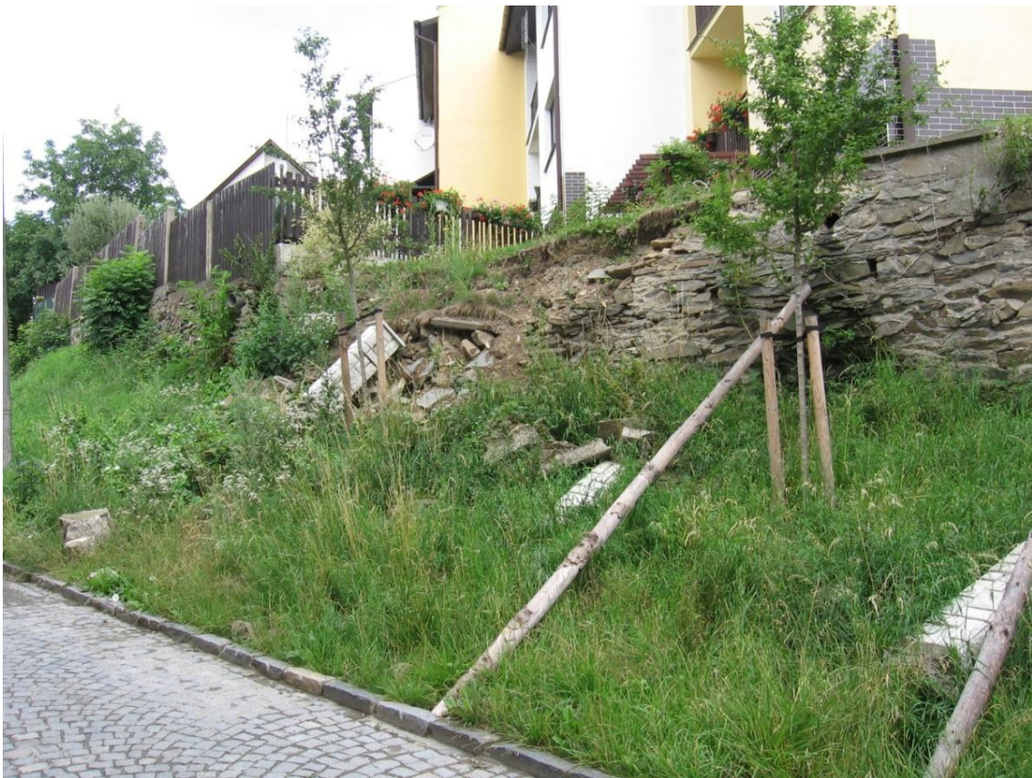
Obr. 42: Původní stav před začátkem realizace projektu. Foto: Mgr. Kostrůnek, 2008
