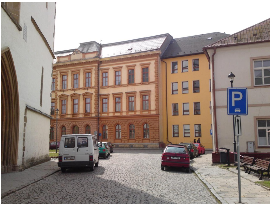
Obr. 34: Budova OA a SPŠ Uničov Foto: Autor, 2012
