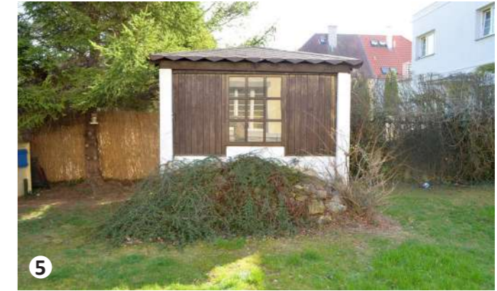
Obr. 101 Pohled na besídku
