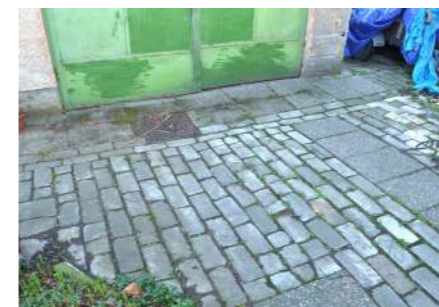
Obr. 184 Dochovalá původní dlažba
