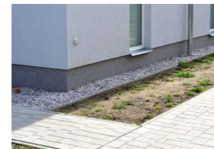
Obr. 185 Současné řešení okapového chodníku
