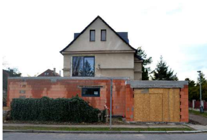
Obr. 107 Stav po rekonstrukci
