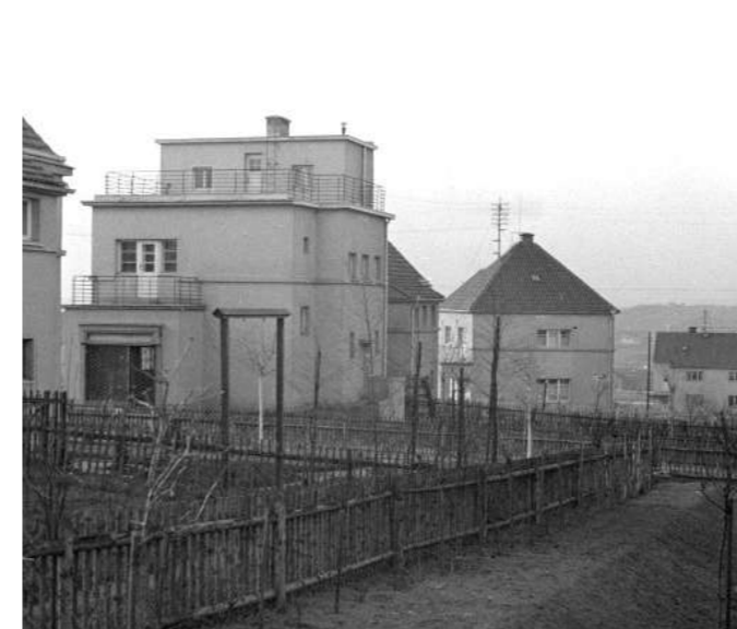
Obr. 120 Dřevěné ploty směrem k hospodářským uličkám
