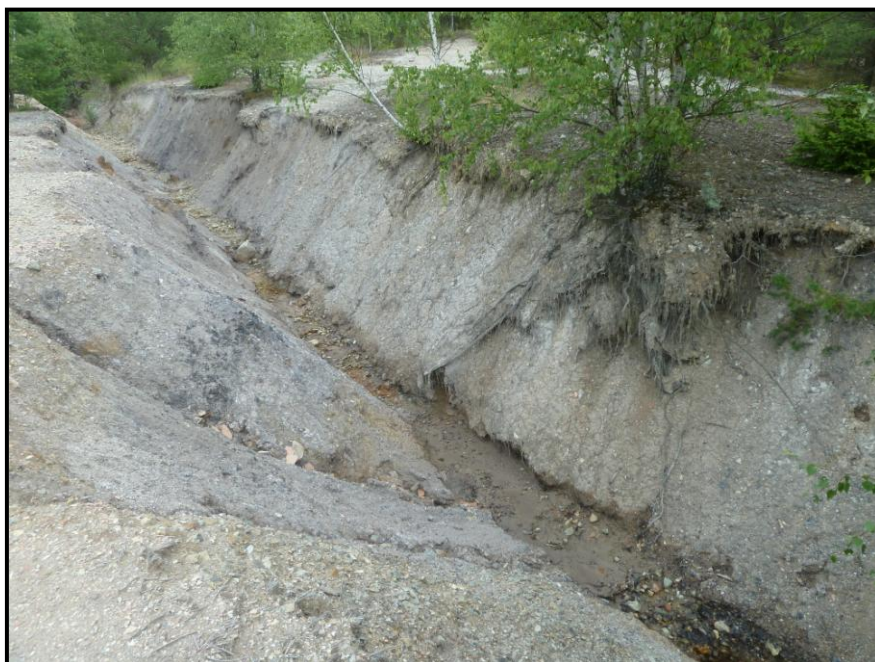
Obr. 28: Svodný příkop (foto Jiří Ivanič, 2019)
