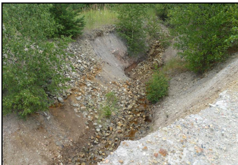
Obr. 16: Svodný příkop (foto Jiří Ivanič, 2019)
