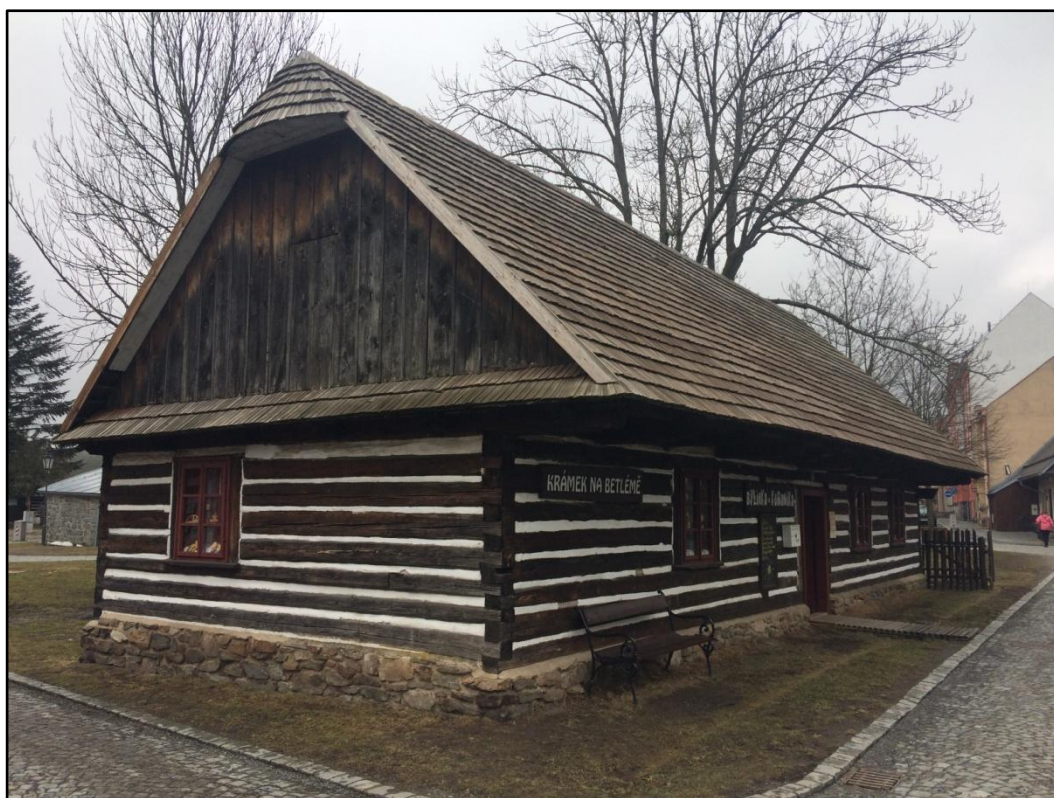
Obrázek 13 - Roubenka se sedlovou střechou s podlomením a kabřincem, zdroj: archiv autora
