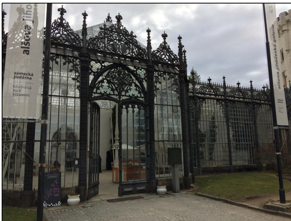
Obrázek 9 - Litinová konstrukce zimní zahrady na zámku Hluboká, zdroj: archiv autora
