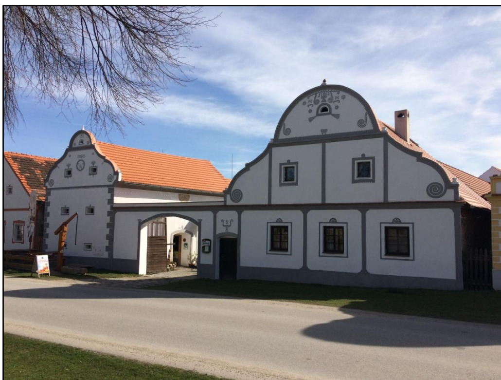
Obrázek 15 - Štítové průčelí s volutami u domku č.p. 3 v Holašovicích, zdroj: archiv autora
