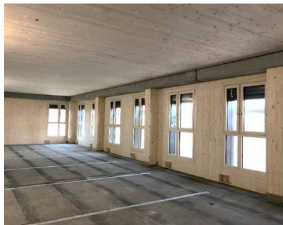
Obr. č. 43: Pohled z interiéru budovy na CLT panely [38]
