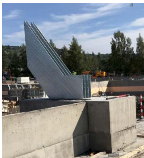
Obr. č. 21: Ocelové plechy pro upevnění patky rohového sloupu na staveništi [25]
