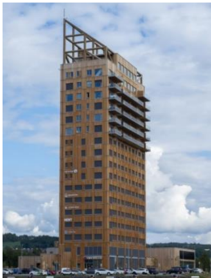
Obr. č. 18: Budova Mjøstarnet v Norsku [24]
