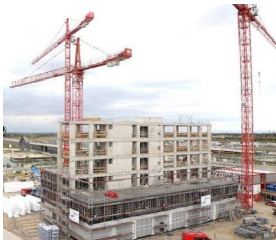
Obr. č. 42: Výstavba betonového jádra [38]
