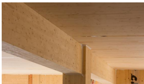
Obr. č. 36: Napojení nosníku na sloup [33]
