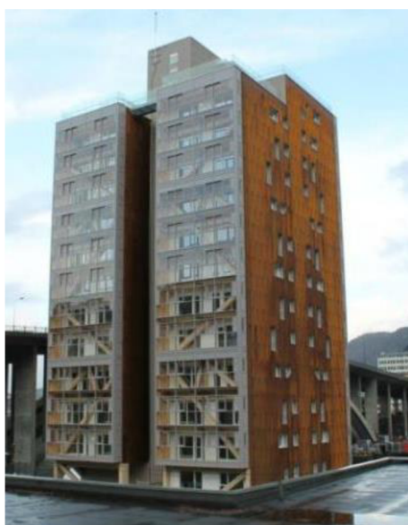
Obr. č. 24: Budova Treet v Norsku [29]
