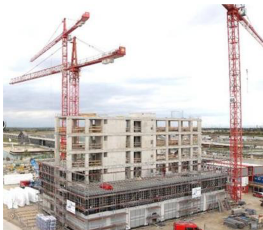
Obr. č. 42: Výstavba betonového jádra [38]
