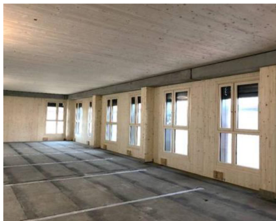
Obr. č. 43: Pohled z interiéru budovy na CLT panely [38]
