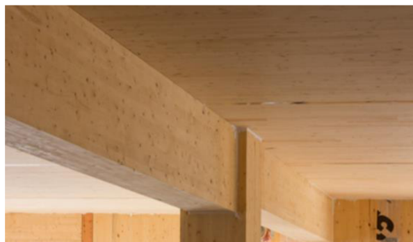
Obr. č. 35: Schéma detailu napojení sloupu na nosník [33] Obr. č. 36: Napojení nosníku na sloup [33]
