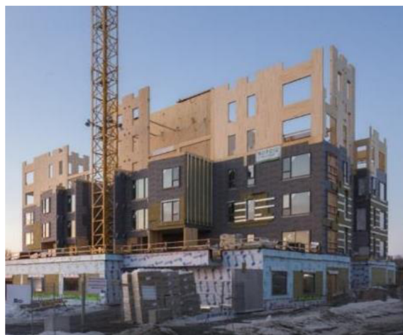
Obr. č. 30: Výstavba budovy Condos Origine v Kanadě [34]
