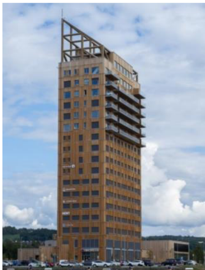
Obr. č. 18: Budova Mjøstarnet v Norsku [24]
