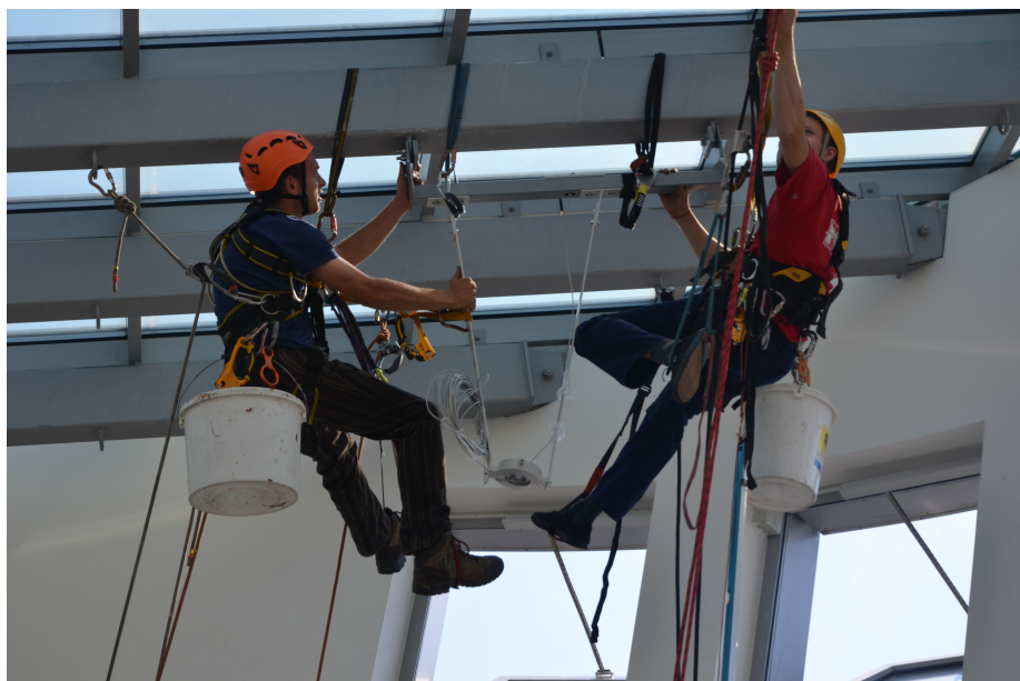
Obrázek 8: Zavěšování závěsu se zařízením pro uchycení Charronova prstence.
