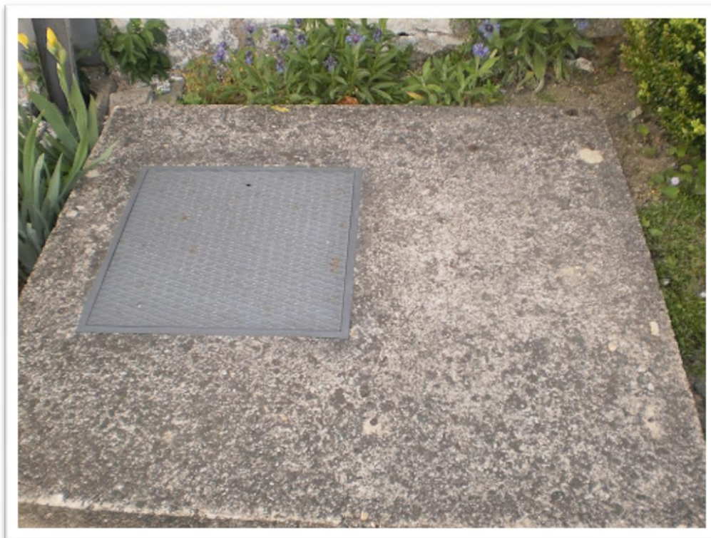
Obrázek č. 3 – Vodoměrná šachta
