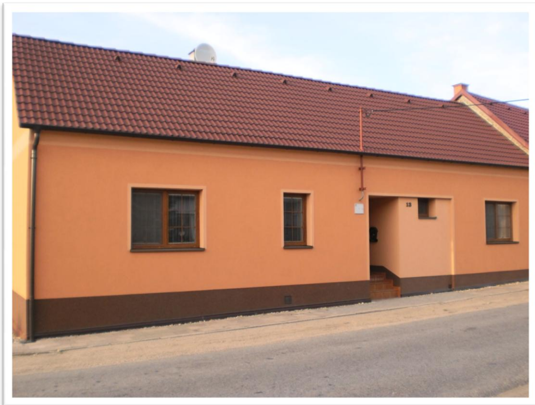
Obrázek č. 2 – Rodinný dům, čelní pohled
