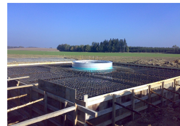
Celková armovací výztuž
