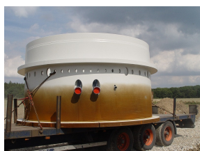
Přeprava ocelového fundamentu
