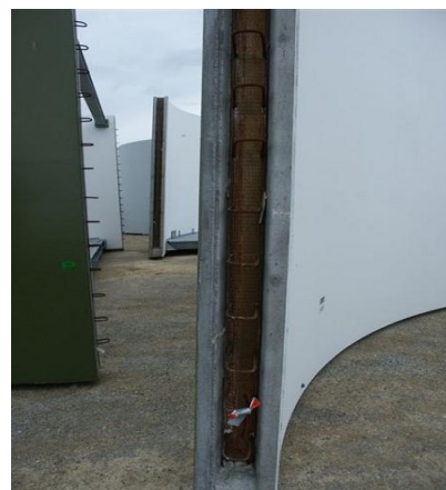
Obr. 15: Detail ocelové výztuže
