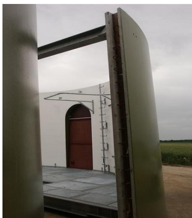
Obr. 14: Základová poloskořepina včetně dveří
