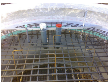
Potrubií vyvádí výkonovou kabeláž ven z betonového základu
