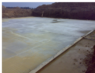
Betonová deska, na níž bude vybetonován vlastní základ elektrárny
