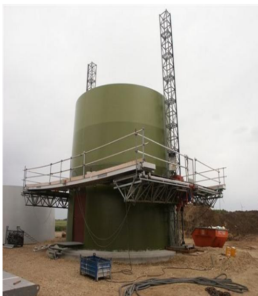
Obr. 16: Umístění prvních dvou prstenců.
