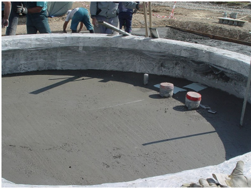
Pohled dovnitř vybetonovaného fundamentu
