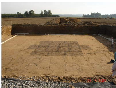
Odkrytá základová spára
