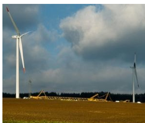
Obr. 1: Větrné elektrárny Věžnice
