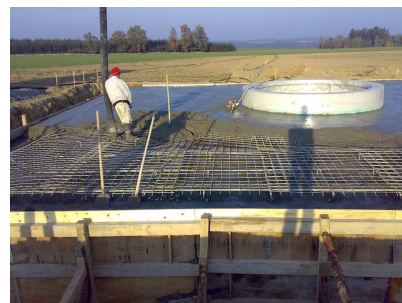
Čekání na beton
