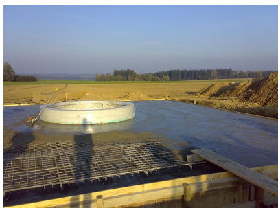
Postupné betonování základu
