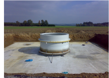
Přesné usazení fundamentu na určené místo
