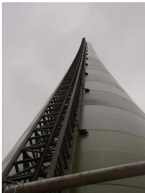
Obr. 18: Celkový pohled na stožár
