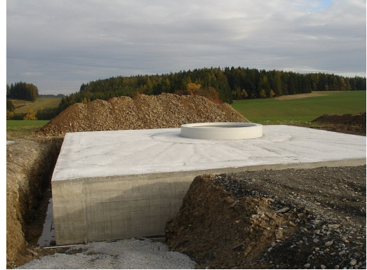
Celkový pohled na hotový železobetonový základ větrné elektrárny
