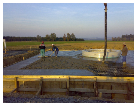
Horní plocha základu se spáduje k okrajům, aby voda odtékala mimo
