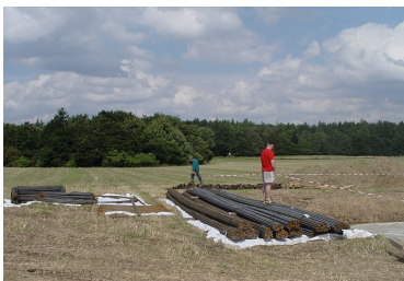
40 tun armovacího železa
