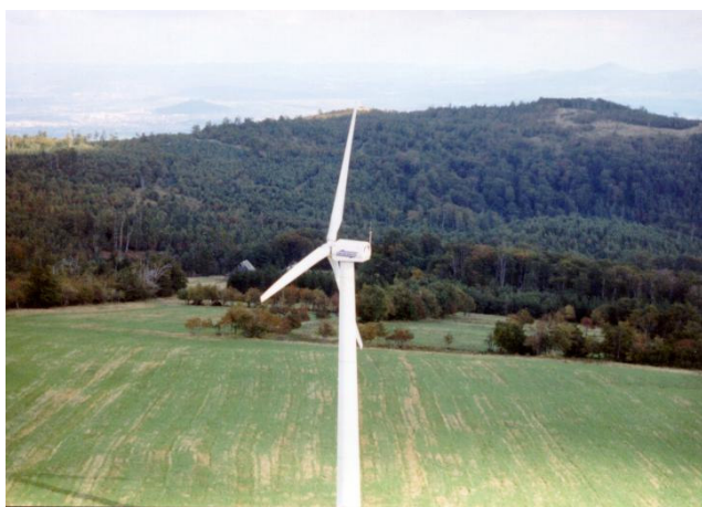
Obr. 2: Větrná elektrárna Dlouhá louka
