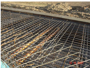
Potrubií vyvádí výkonovou kabeláž ven z betonového základu
