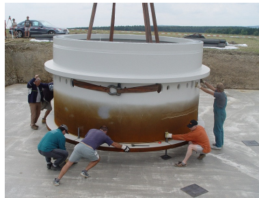
Přesné usazení fundamentu na určené místo
