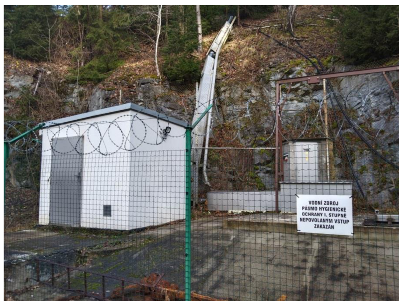
Obrázek 38: Ochrana I. pásma (Zdroj: V. Kordulová, prosinec 2022)
