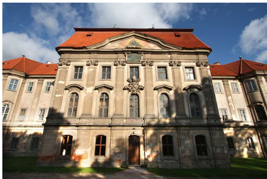
Obr. 10: Klášter Plasy, východní průčelí konventu
