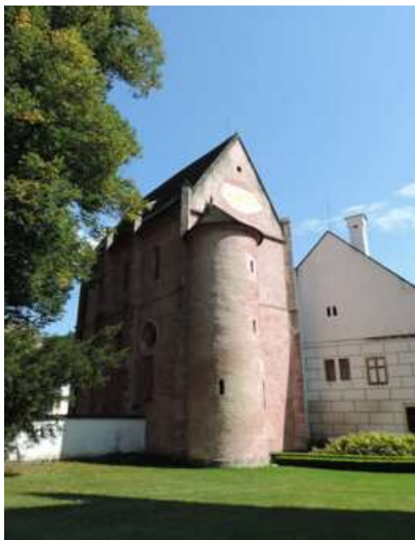
Obr. 34: Kaple Andělů Strážných, Zlatá Koruna
