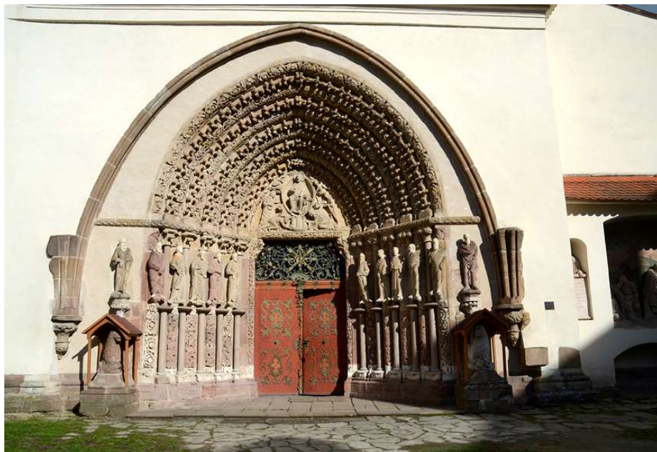
Obr. 28: Portál kláštera v Tišnově
