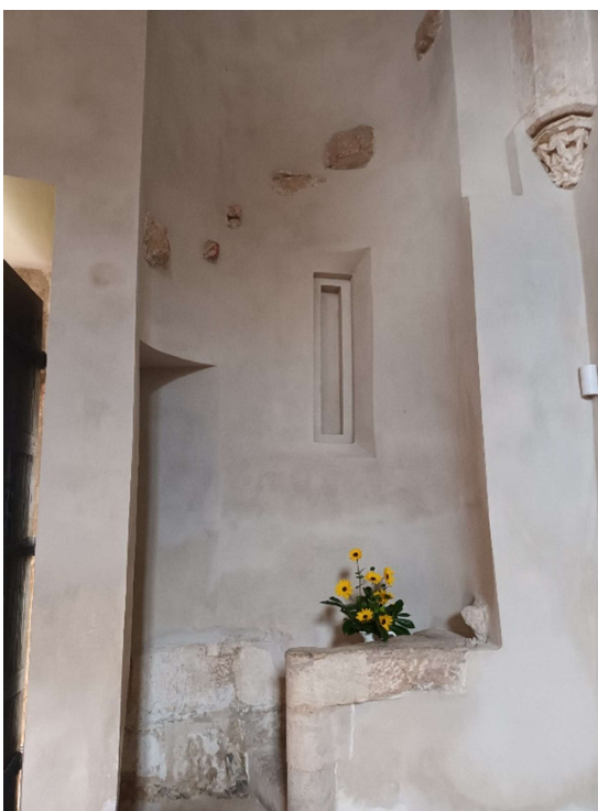
Obr. 41: Fragment původního točitého schodiště, kaple Andělů Strážných
