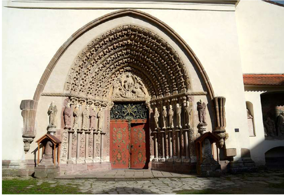
Obr. 28: Portál kláštera v Tišnově
