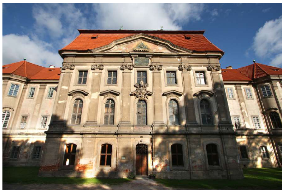
Obr. 10: Klášter Plasy, východní průčelí konventu
