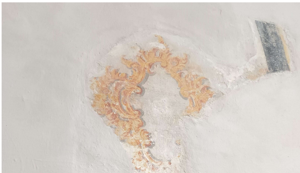
Obr. 53: Ornamentální prvek, kaple Andělů Strážných
