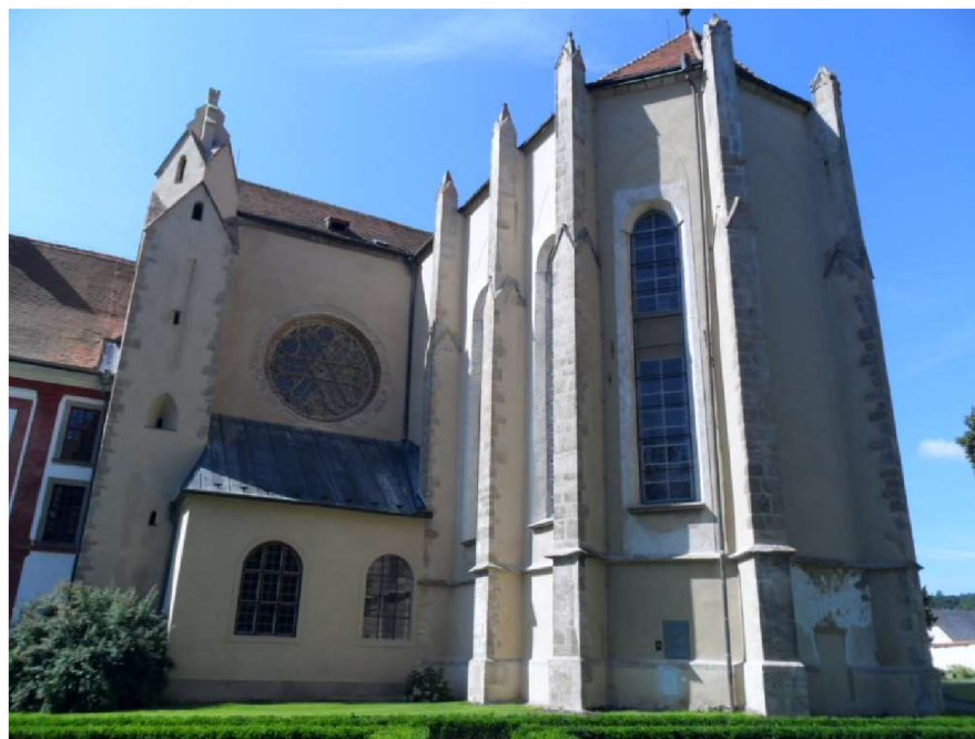
Obr. 35: Kostel Nanebevzetí Panny Marie, Zlatá Koruna
