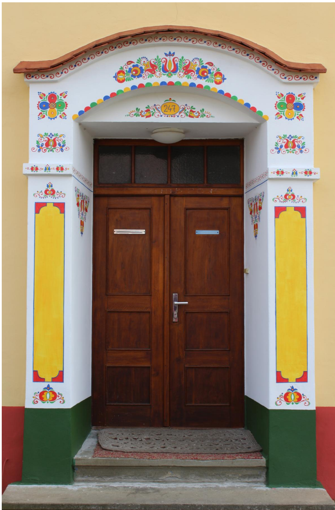
Příloha č. 26 - Vstupní žudro do budovy farního úřadu v Mikulčicích
