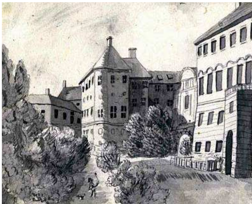
11. Bedřich ze Schwarzenbergu, Hlubocké předzámčí, pohled z panské zahrady –vpravo jižní průčelí zámku, za ním průčelí stájí, uprostřed byty kaplana a úředníků, vlevo kanceláře, 20./30. léta 19. století
