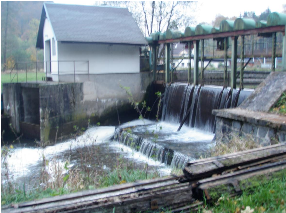
Obr. 25 Zpevnění koryta se stavidlem pro regulaci toku (Autor: D. Honka, říjen 2014)
