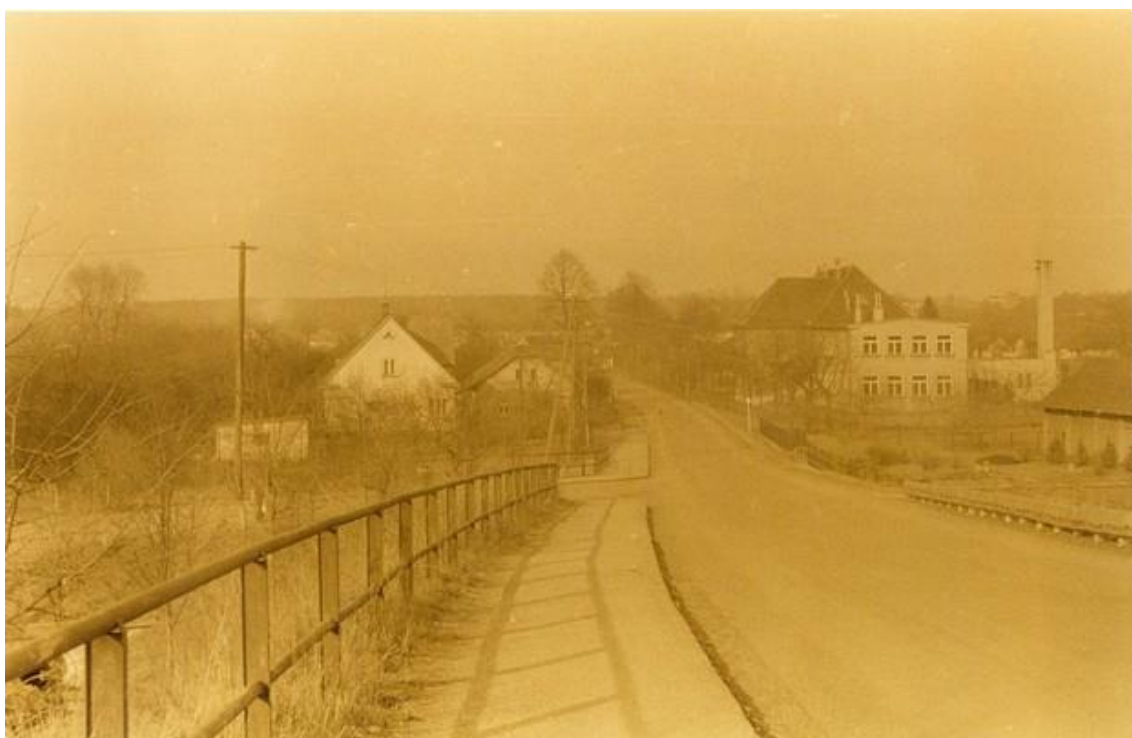
obr. 29 - Silniční nadjezd (autor neznámý)
