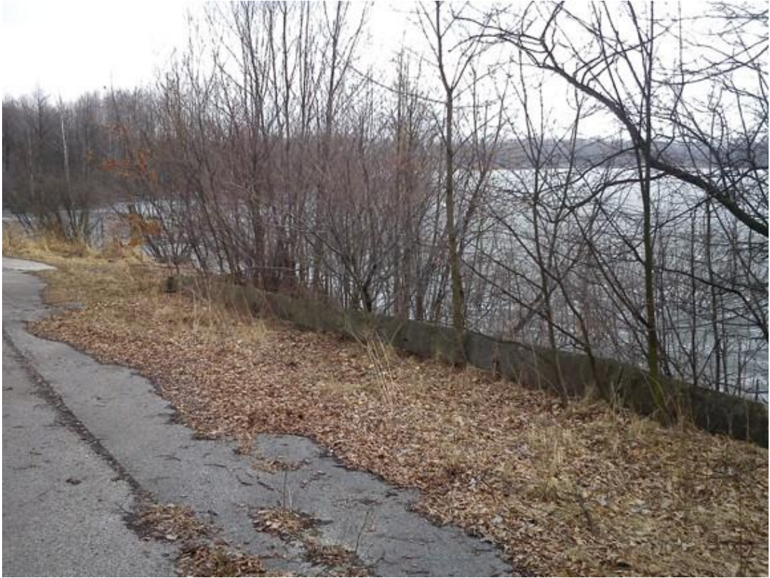
obr. 30 - Pozůstatek silničního nadjezdu (Pavlicová, 2012)
