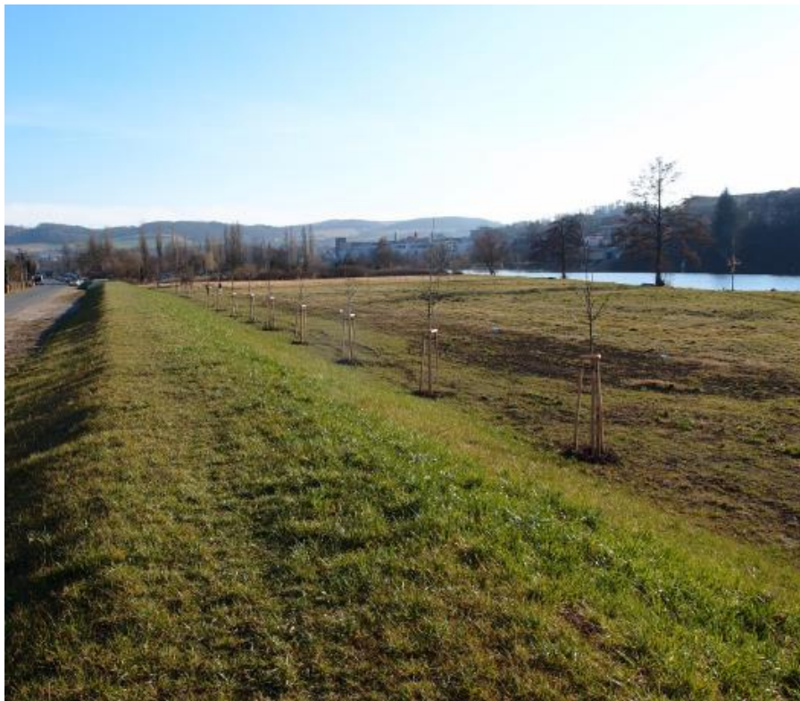
Obr. 6 Protipovodňová ochranná hrádza [11]
