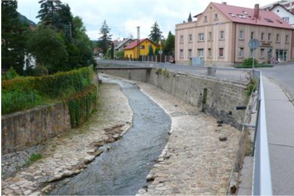
Obr. 3 Príklad technickej úpravy koryta [8]
