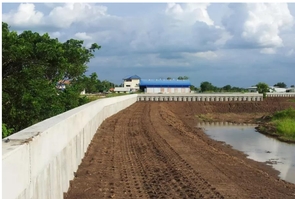
Obr. 4 Stabilná ochranná protipovodňová stena [5]
