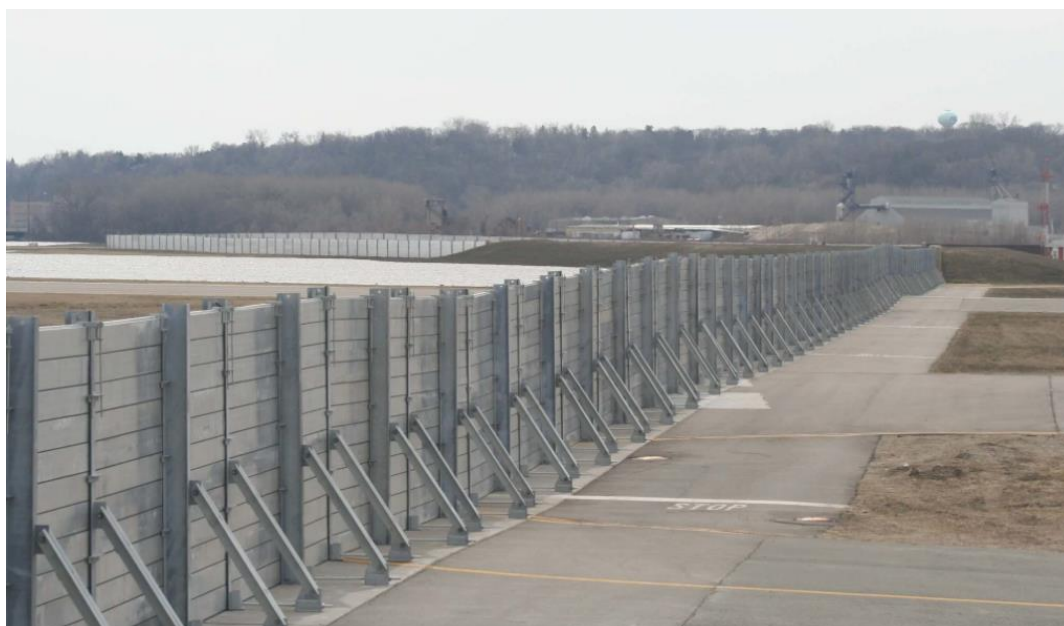
Obr. 5 Mobilná ochranná protipovodňová stena [6]
