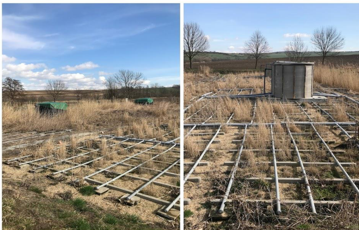
Obrázek 12: Třetí kořenové pole (vertikální čištění)
