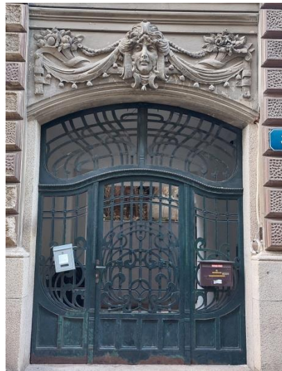
Obr. 19: Detail železné mříže
