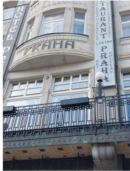
Obr. 9: Detail kovaného zábradlí
