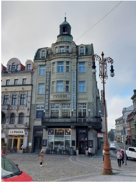
Obr. 8: Pohled na hotel Praha
