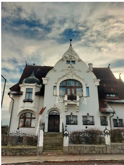
Obr. 12: Průčelí domu z Husovy ulice
