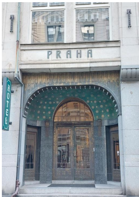
Obr. 10: Hlavní vstup do hotelu
