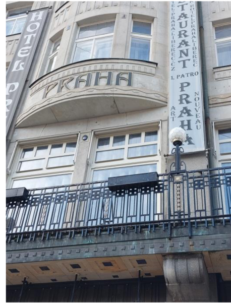
Obr. 9: Detail kovaného zábradlí
