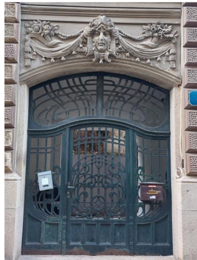
Obr. 19: Detail železné mříže
