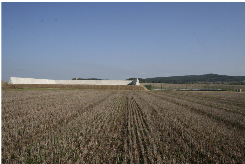
Foto 5.1.5.2. Pevné hnojiště – pohled na hnojiště od vsi
