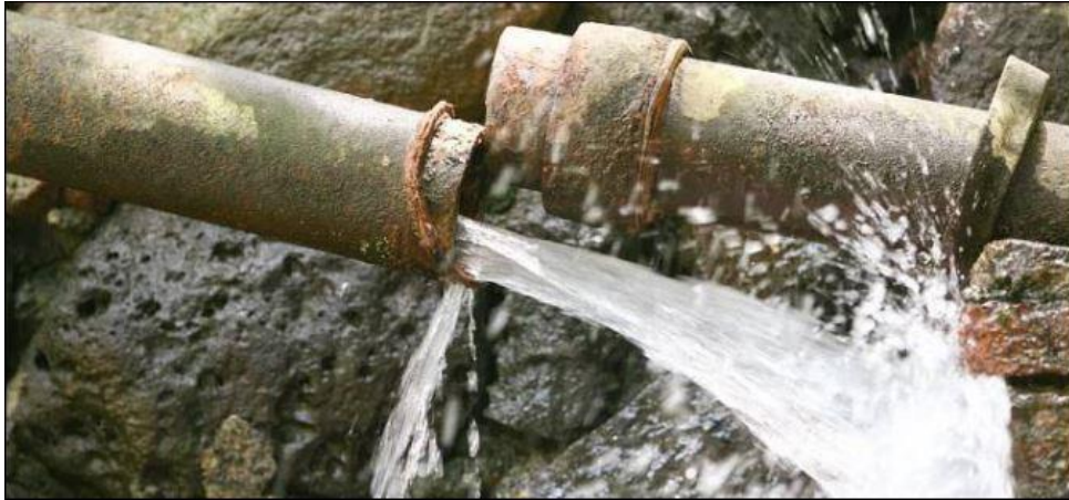
Obrázek 8: Porucha na vodovodní síti (Interní materiály ČEVAK a.s.)
