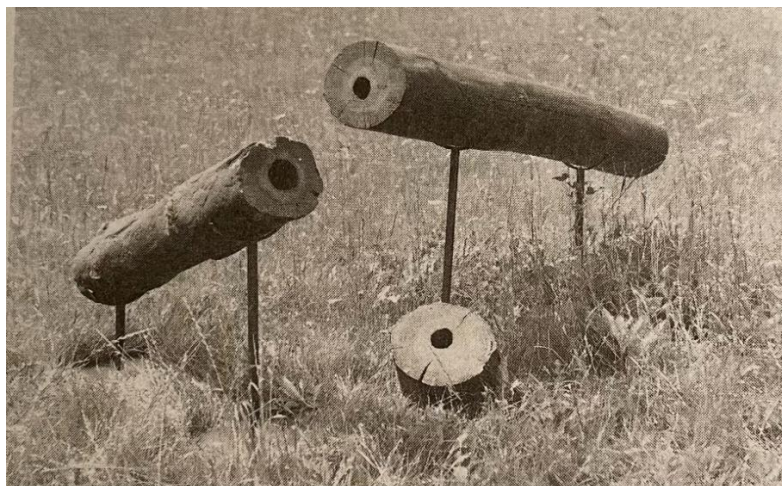
Obrázek 3: Středověké dřevěné vodovodní potrubí (Jásek a kol., 2000)
