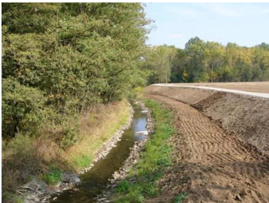
Obrázek 42 Stav lokality po výstavbě selské hráze severně od obce Horka nad Moravou sloužící jako ochrana proti povodním (foto: Kohoutek, 2012)
