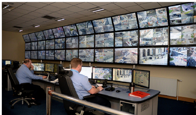
Obr. 2.4: Príklad kontrolnej miestnosti kamerových systémov (zdroj [58]).
