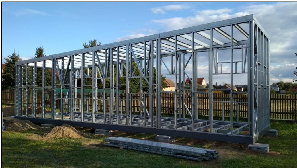
Obr. 11. Příklad lehkého ocelového konstrukčního systému [46]
