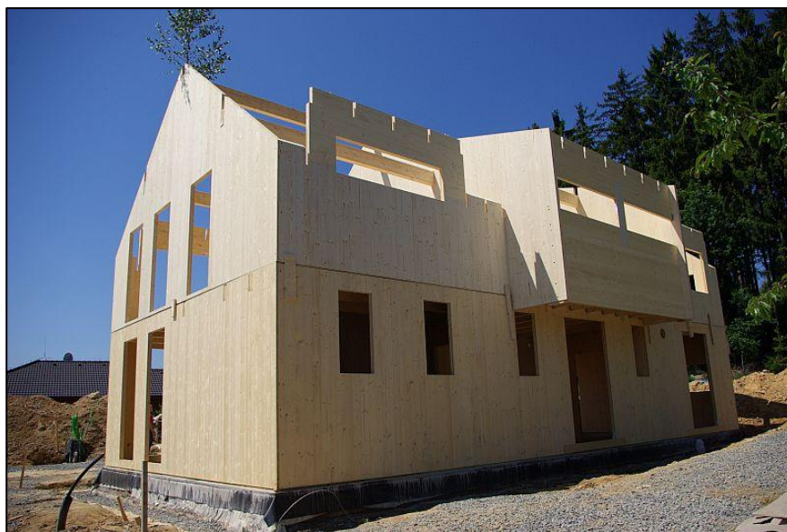
Obr. 7. Příklad konstrukce z CLT panelů [38]
