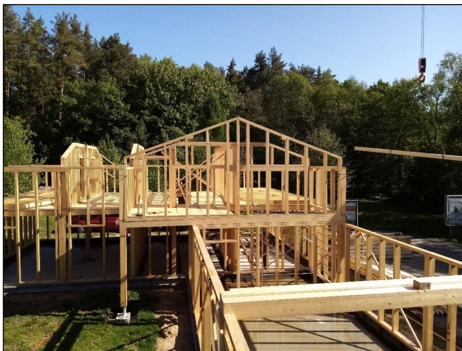
Obr. 9. Příklad rámové konstrukce dřevostavby [41]
