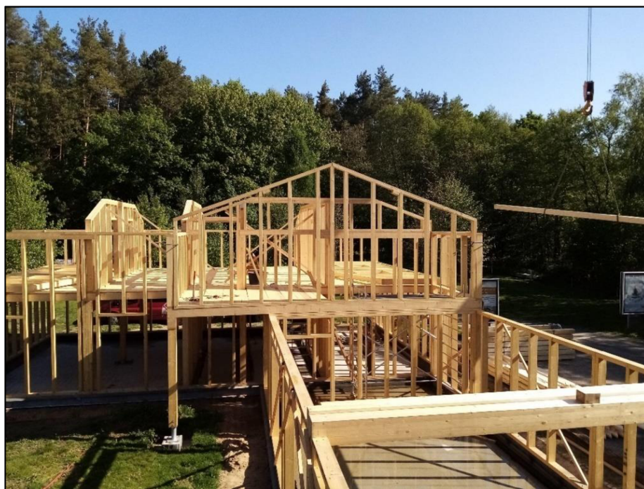
Obr. 9. Příklad rámové konstrukce dřevostavby [41]
