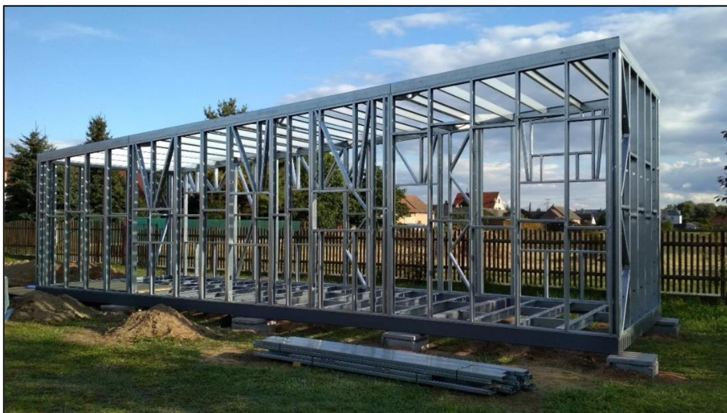
Obr. 11. Příklad lehkého ocelového konstrukčního systému [46]
