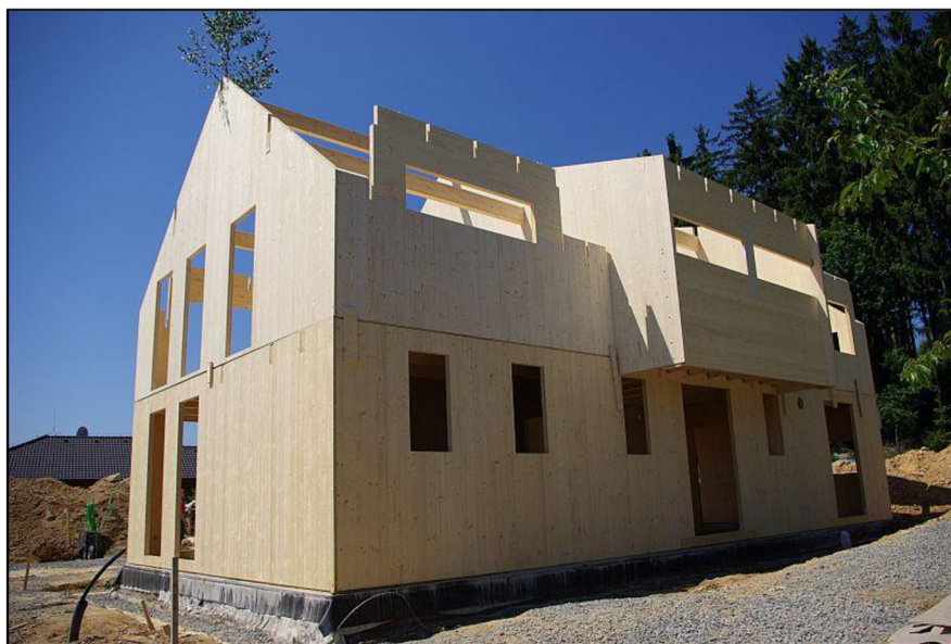
Obr. 7. Příklad konstrukce z CLT panelů [38]
