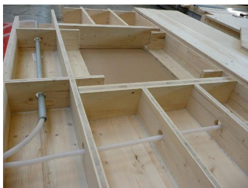
Obr. 10 Montáž panelů element (novatop-system.cz)
