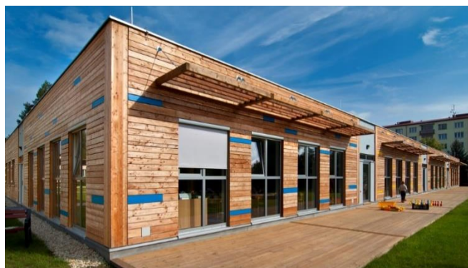
Obr. 1 Mateřská školka v Mariánských lázních (stavebnictvi3000.cz)
