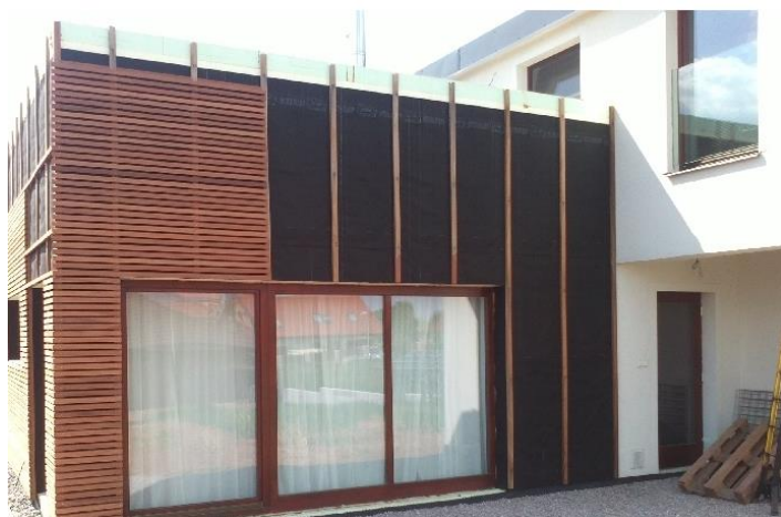
Obr. 12 Fasáda tvořena latěmi (europanel.cz)
