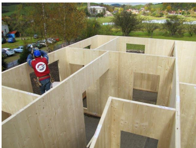
Obr. 8 Novatop Solid realizace (novatop-system.cz)
