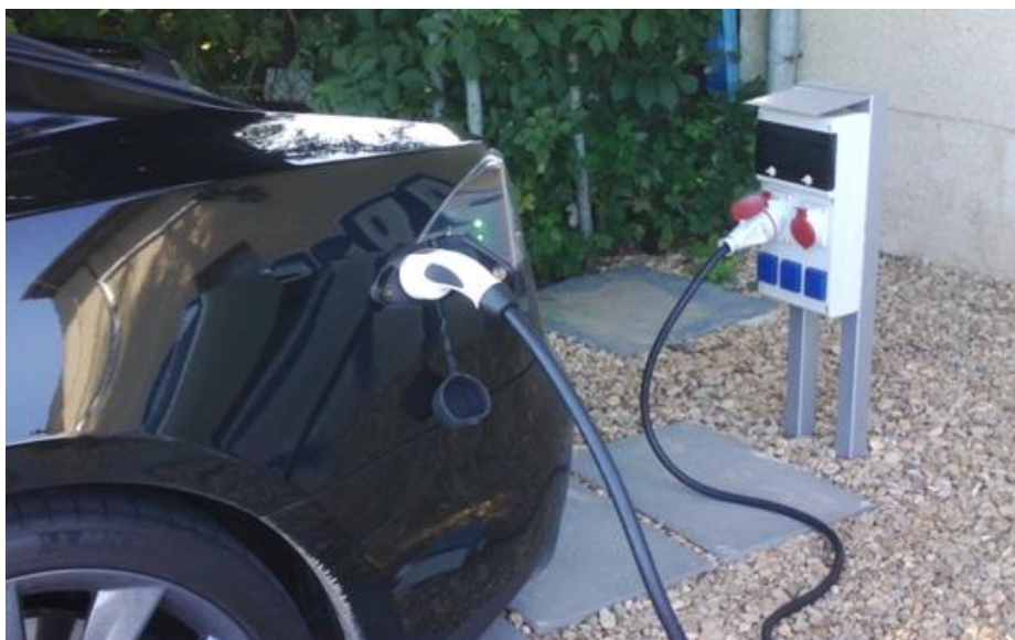
Obrázek 10: Sloupek se zásuvkami pro všechny varianty AC dobíjení
