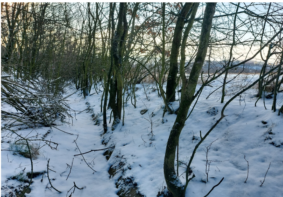
Koryto příležitostně vodoteče opevněné betonovými tvarovkami (polní mez pod PP Hřebený – Řitka)
