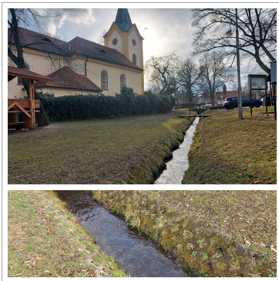
Obrázek 30: Opatření proti nepříznivým účinkům povodní a sucha na Bojovském potoce: napřímené koryto v intravilánu obce (nahore), koryto opevněné tvarovkami umožňujícími průsak (dole), k. ú. Kytín
