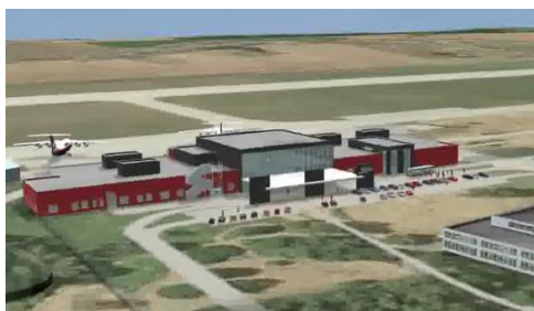
Obr. 8: Nová odbavovací hala, pohled na vstupní část
