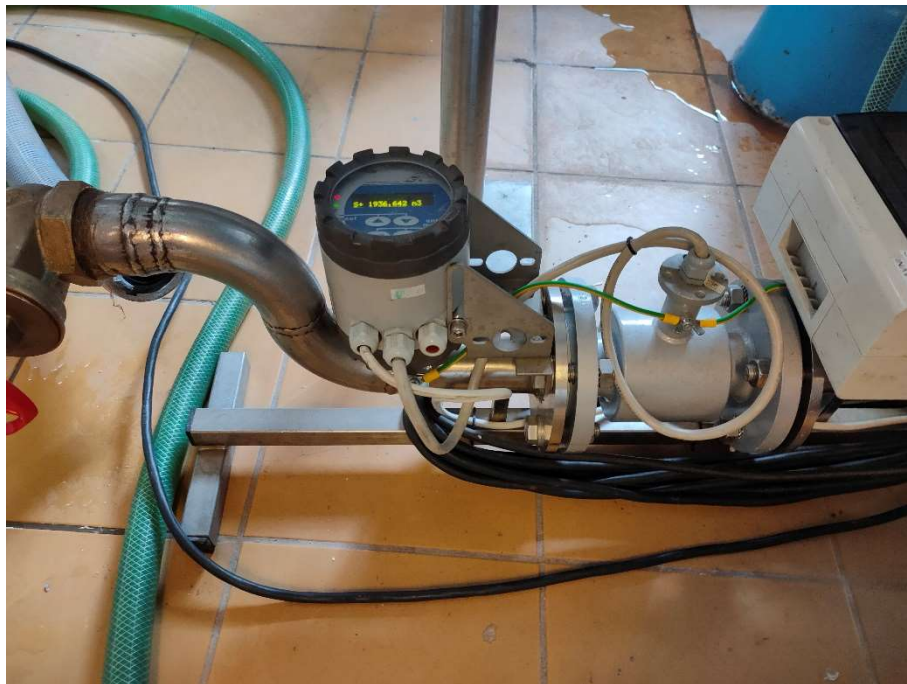
Obrázek 8 Elektromagnetický indukční průtokoměr DN50
