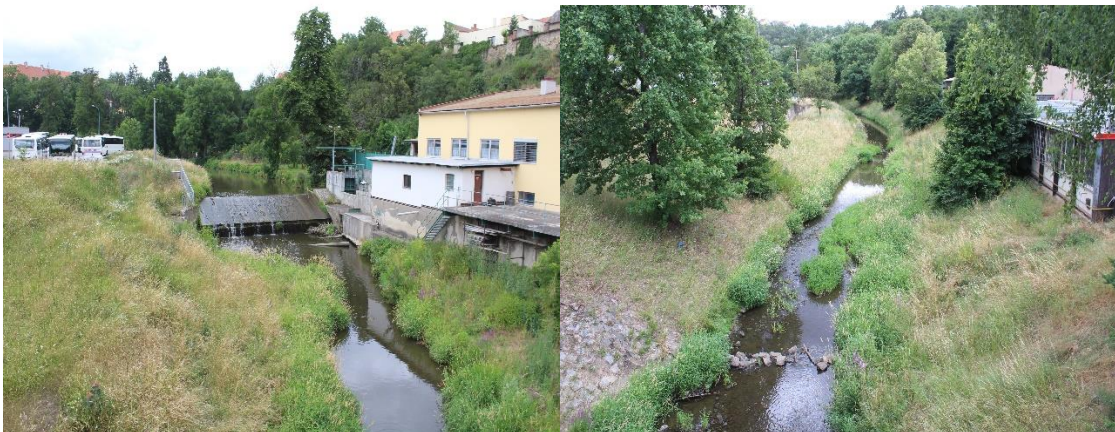
Obr. 37: Rokytná v Moravském Krumlově před a za MVE ř. km 14,5
