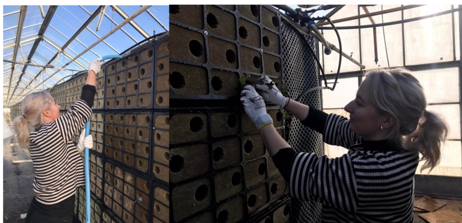
Příloha 3: Zavlažení systému Biotile před osázením, následné osázení systému, Klára Jiřincová, 2022
